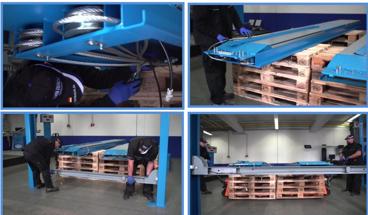
Heben Sie nun die Traverse vorsichtig in die Rastposition an, in der ihre Auflagefläche ein Stück höher wie die Auflagefläche der Fahrbahnen liegt. Achten Sie darauf die Traverse nicht zu hoch anzuheben, da sonst der Hub der Flurförderzeuge nicht ausreicht um sie unter die Fahrbahnen zu schieben.
