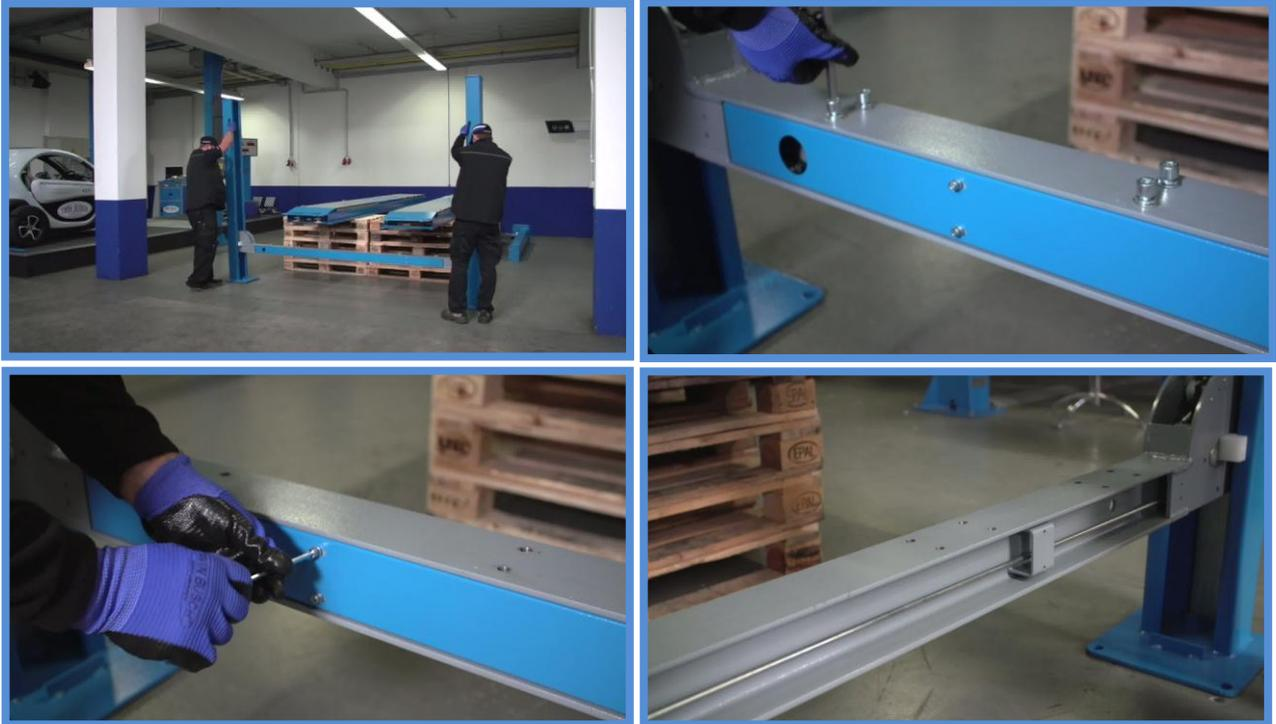
Jetzt entnehmen wir die Stahlseile aus der linken Fahrbahn. Das kurze Seil wird später an die linke vordere Säule und das lange Seil an die Säule vorne rechts geführt.
