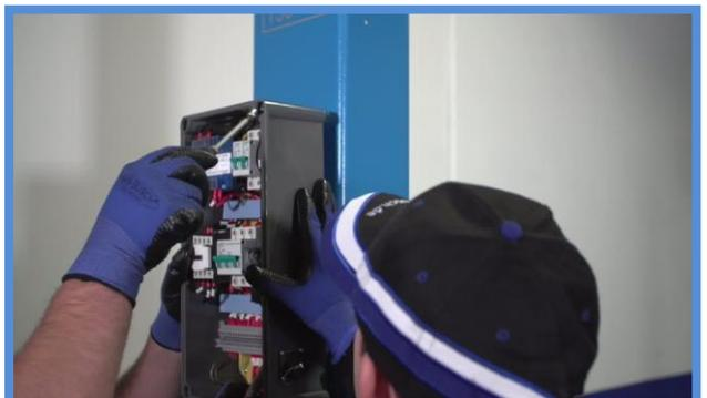
Für eine optimale Tätigkeit müssen Sie den Endabschalter leicht vorkonfigurieren. Öffnen Sie dazu die Schraube zum justieren des Schaltarms und ziehen sie diesen ein Stück weit heraus.
