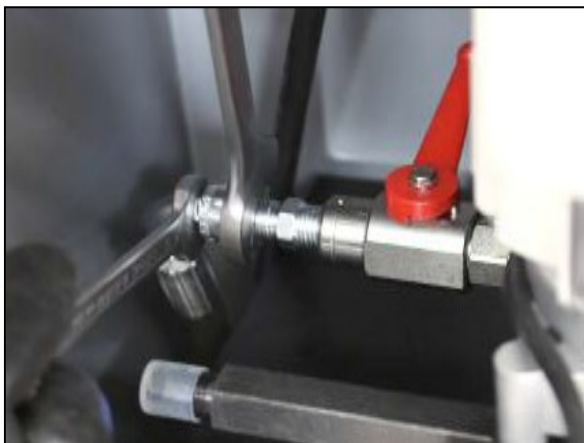
Abbildung: Festziehen der Leitungen
