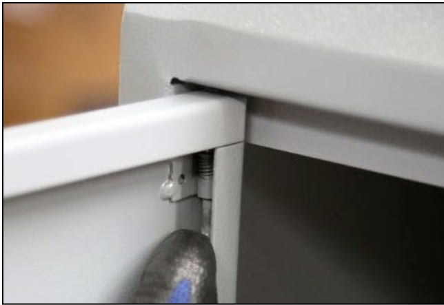
Abbildung: Aushängen der Schaltkastentür
